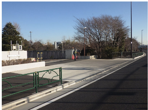
歩道切り下げ状況
