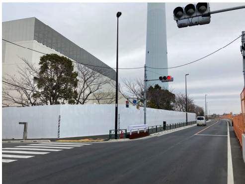
仮囲い設置状況
