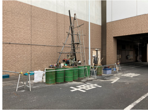
地盤調査状況
