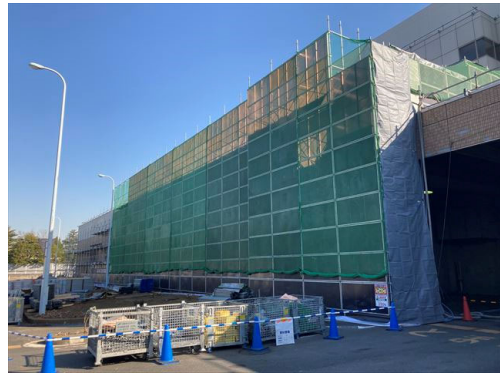
工場棟北面足場組立状況
