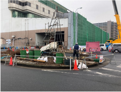
地盤調査状況
