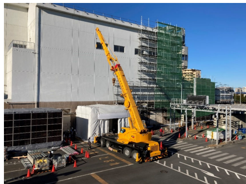
工場棟東面足場組立状況
