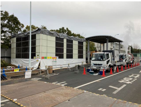
付属棟石綿養生状況
