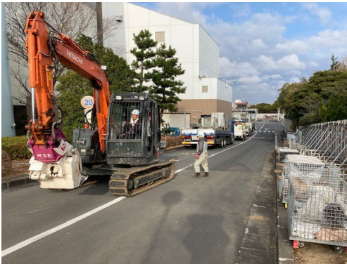
解体工事着手状況
