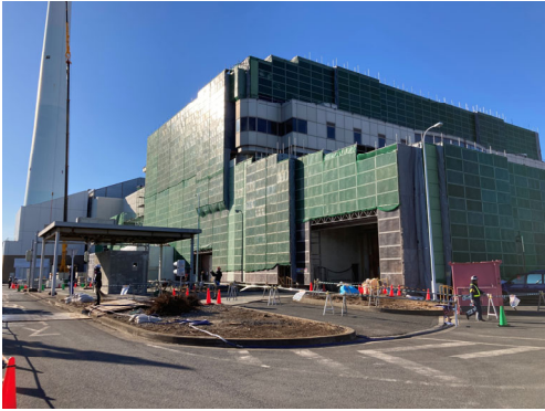
工場棟北東全景
