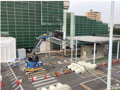
付属棟解体状況
