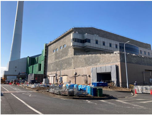
工場棟北東全景
