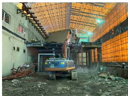
管理諸室低層部解体状況
