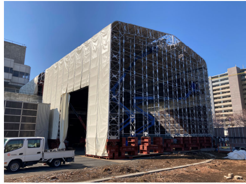
管理諸室テント組立状況
