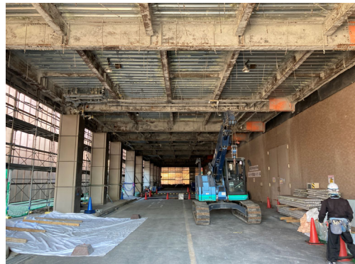
管理諸室天井断熱材撤去
