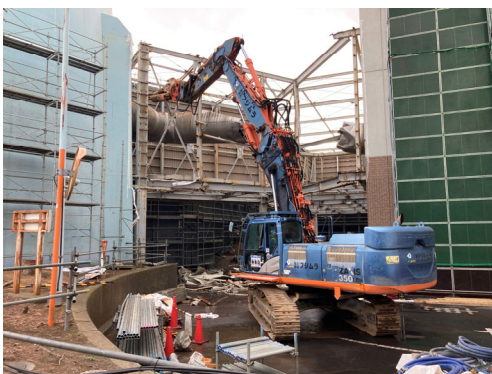
煙道囲い解体状況
