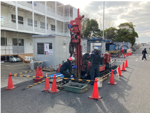
土壌調査状況
