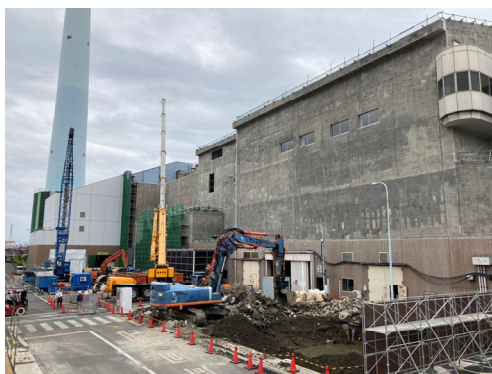
工場棟北東全景
