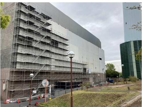
工場棟南面足場組立状況
