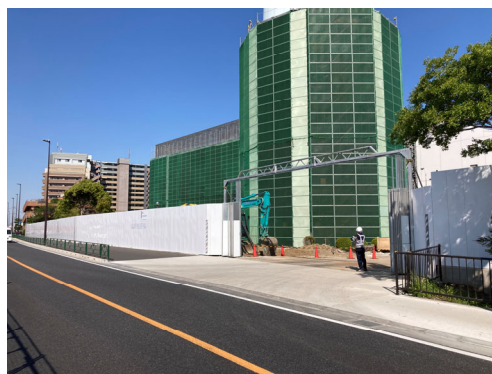
南面ゲート整備状況
