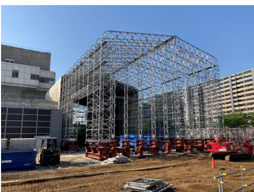
管理諸室テント解体
