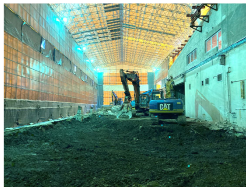
管理諸室低層部解体
