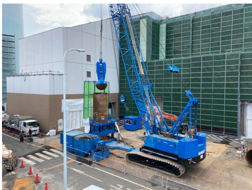
障害撤去状況
