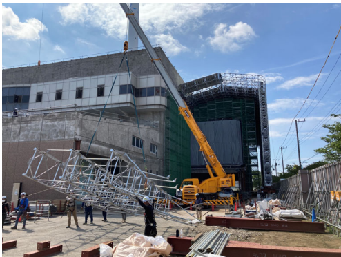
管理諸室高層部テント組立状況(北)
