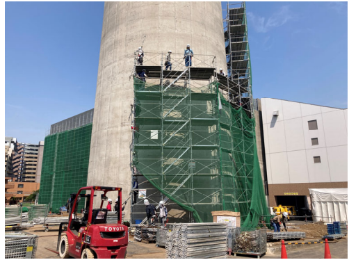
煙突足場 解体状況
