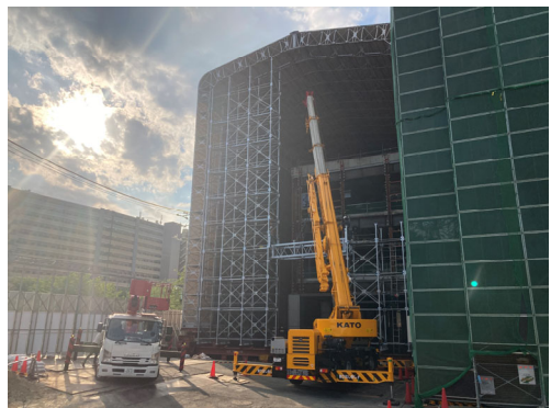
管理諸室高層部テント組立状況(南)
