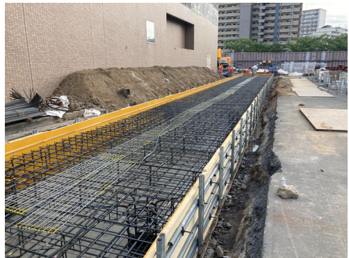
テント基礎設置状況
