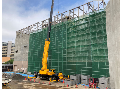
工場棟外壁PC版・ルーバー撤去状況（南側）
