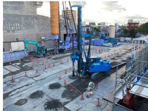
鋼管杭・SMW施工状況（東側）
