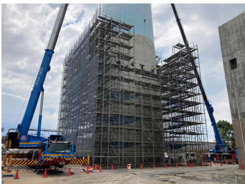
煙突ハットダウン支保工組立状況（南側）
