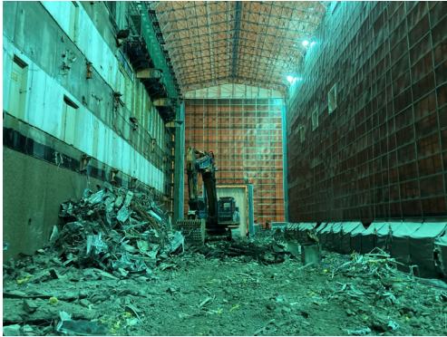
管理諸室高層部解体状況（西側）
