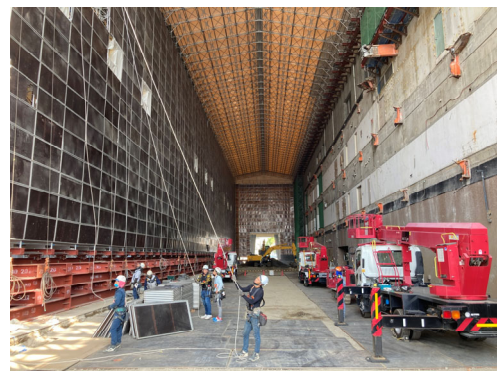
管理諸室解体完了・テント解体状況（西側）
