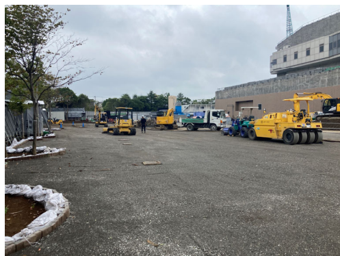
仮補装整地状況（北側）
