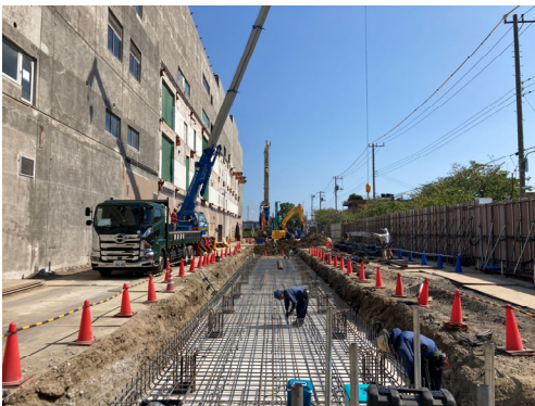
テント基礎工事状況（西側）
