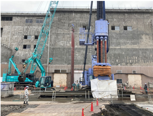
SMW工事状況（東側）
