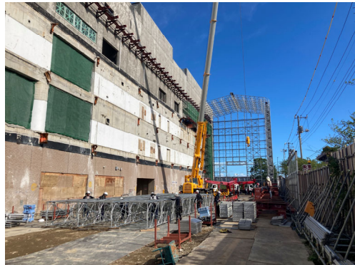
仮設テント解体状況（西側）
