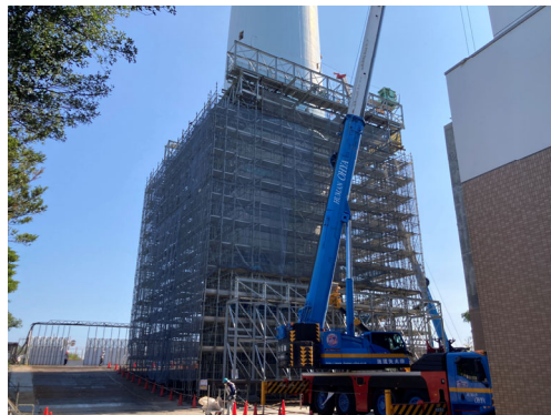
ハットダウンステージ組立状況（南側）
