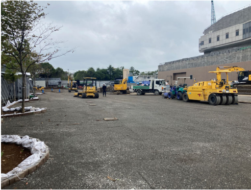
仮設補装整備（北側）
