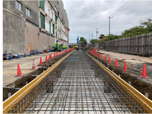
テント基礎CON打設前状況（西側）
