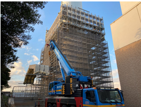
煙突ハットダウンステージ組立（南東側）
