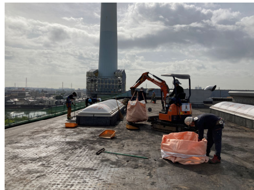
アスファルト防水撤去（工場棟屋上）
