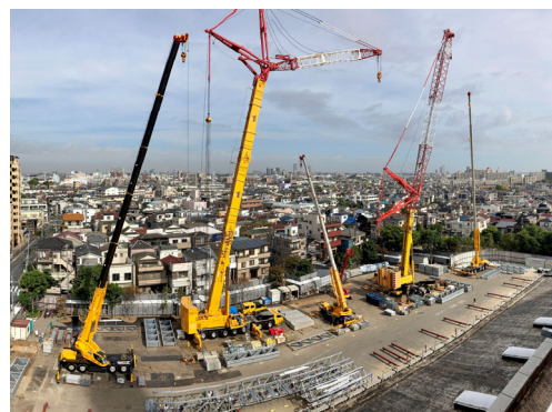
テント組立ヤード遠景（北側）
