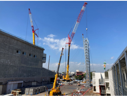
テント壁フレーム組立状況（北側）
