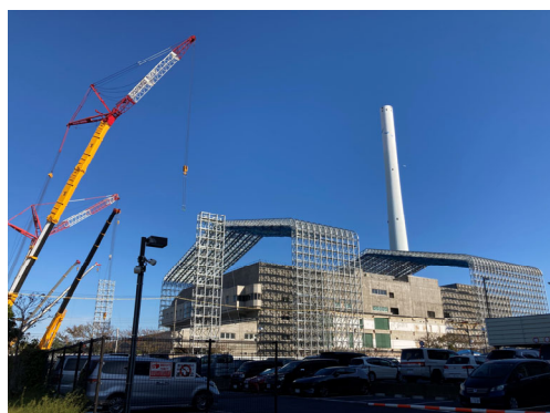
テント組立状況（全景）
