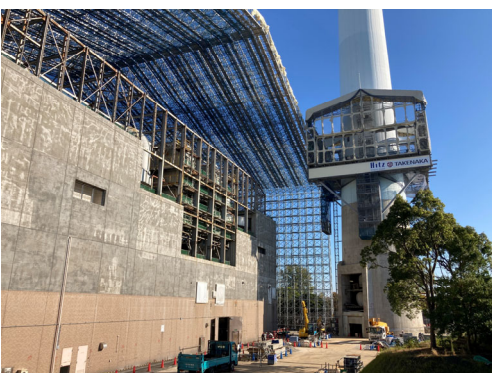
テント・ハットダウンステージ遠景（南側）
