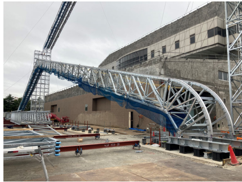
テント屋根フレーム地組状況（北側）
