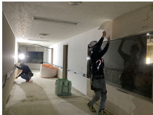
工場棟内装解体状況（1階廊下）
