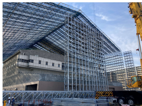
全覆いテント組立状況（北側）
