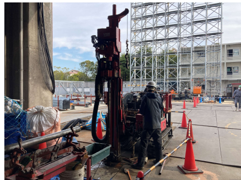
土壌汚染調査状況（工場棟下部）
