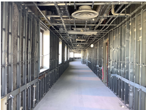
内装解体状況（4F廊下）
