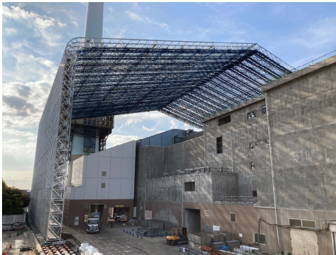
全覆いテント遠景（北東側）
