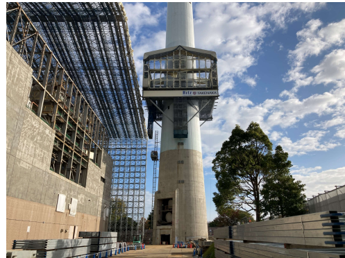
ハットダウンステージ上昇（南側）
