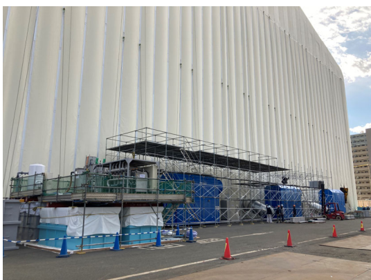
負圧集塵機・水処理設備設置状況（北側）
