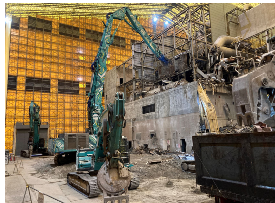
工場棟解体状況（東側）
