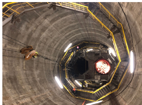
煙突内筒解体状況（南側煙突）
