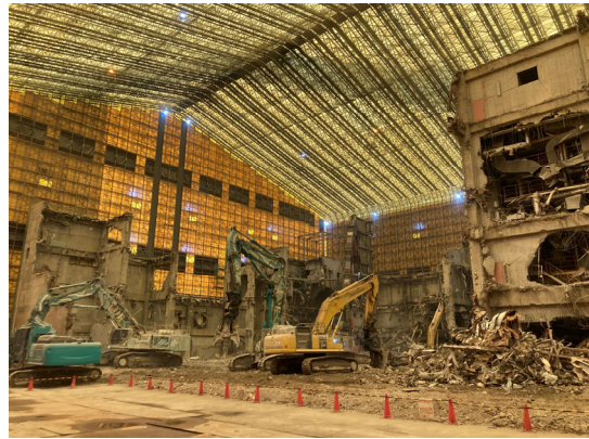
工場棟解体状況（東側）
