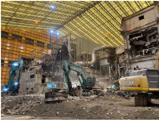
工場棟解体状況（東側）
