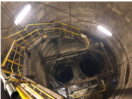
煙突内筒解体状況（地上115m）
