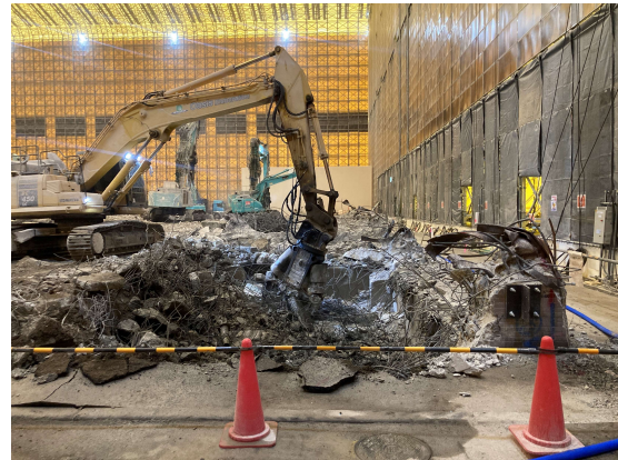
工場棟基礎解体状況（南側）
