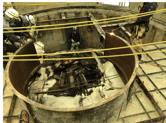
煙突頂部床解体状況
