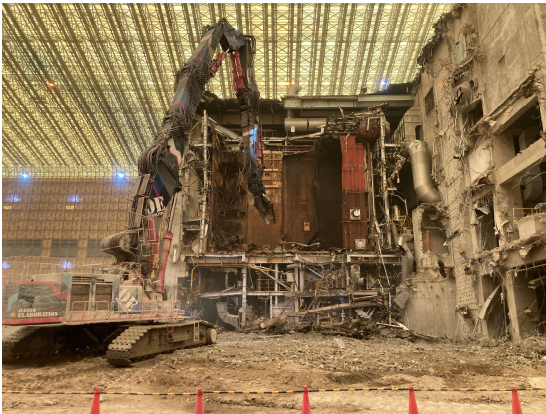
工場棟解体状況（炉室）
