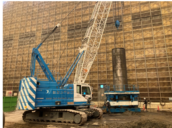
地中障害撤去工事状況（南東側）
