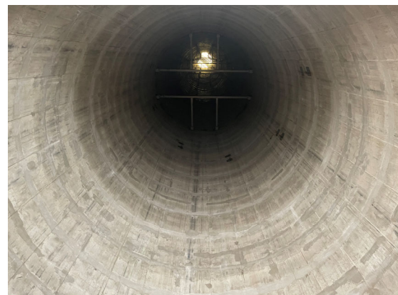
煙突内部解体状況
