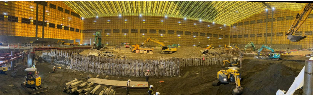
工場棟解体状況（東側）
