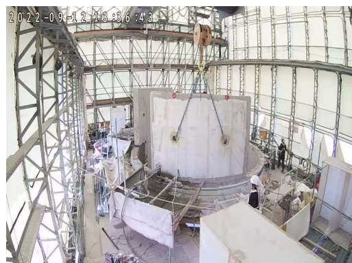
外筒解体状況（煙突）
