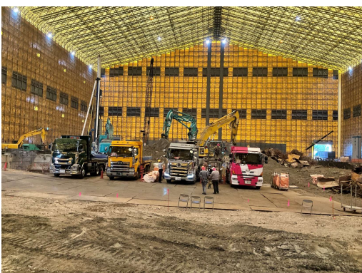
解体材搬出状況（中央）
