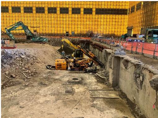
工場棟地盤アンカー施工状況（南側）
