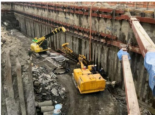
地盤アンカー削孔打設状況（北側）
