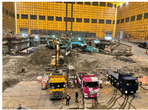
工場棟解体状況（中央）
