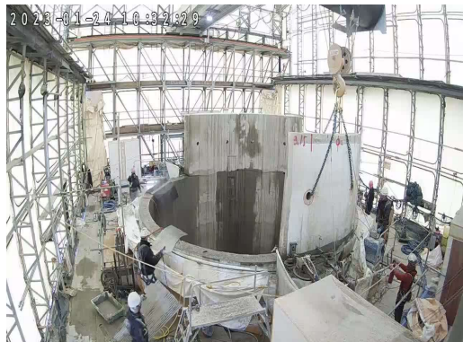
煙突外筒解体状況
