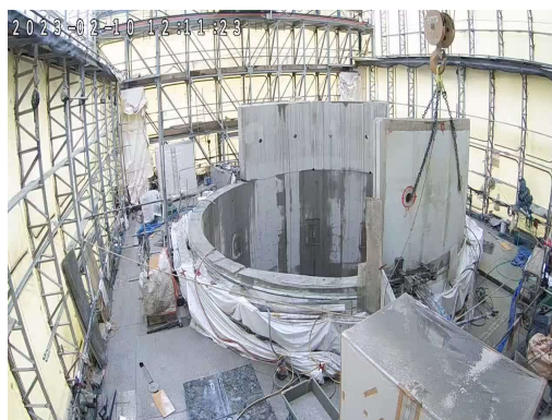
煙突外筒解体状況
