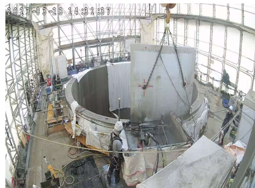
煙突外筒解体状況
