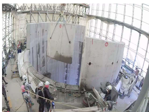
煙突外筒解体施工状況
