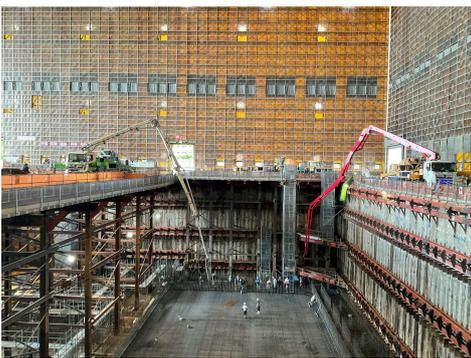
工場棟躯体工事基礎コンクリート打設状況（北側）
