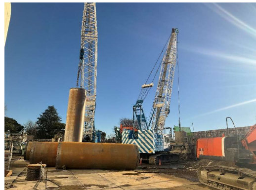
煙突基礎解体障害撤去施工状況
