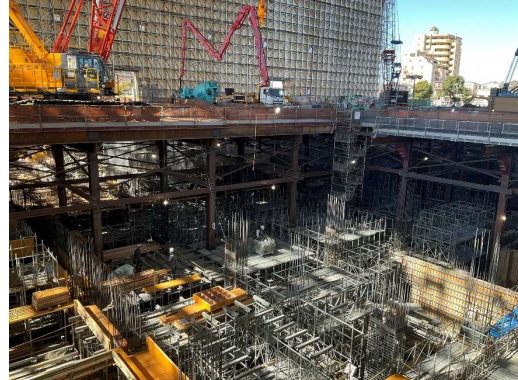
地下2階躯体工事施工状況コンクリート打設（中央部）
