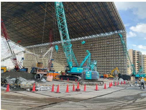
地中障害撤去工事施工状況（北側）
