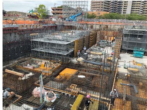
工場棟地下1階躯体工事施工状況（北西部）
