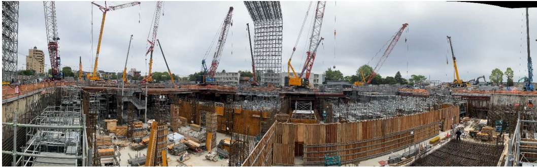
工場棟全景（西側）
