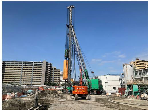
工場棟PHC杭工事施工状況（北側）
