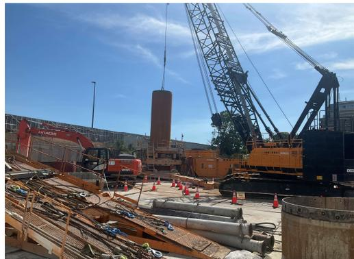
煙突現場打造成杭工事施工状況
