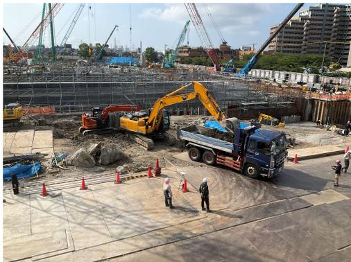
工場棟雨水貯留槽掘削工事残土積み込み状況（北側）
