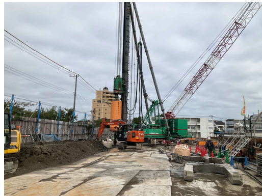
工場棟PHC既製杭杭工事施工状況（西側）
