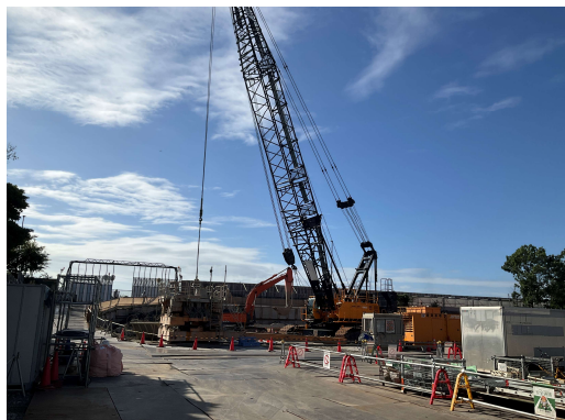
煙突現場打ち造成杭施工状況
