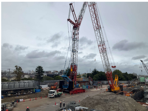
タワーフロント組立状況（東側）
