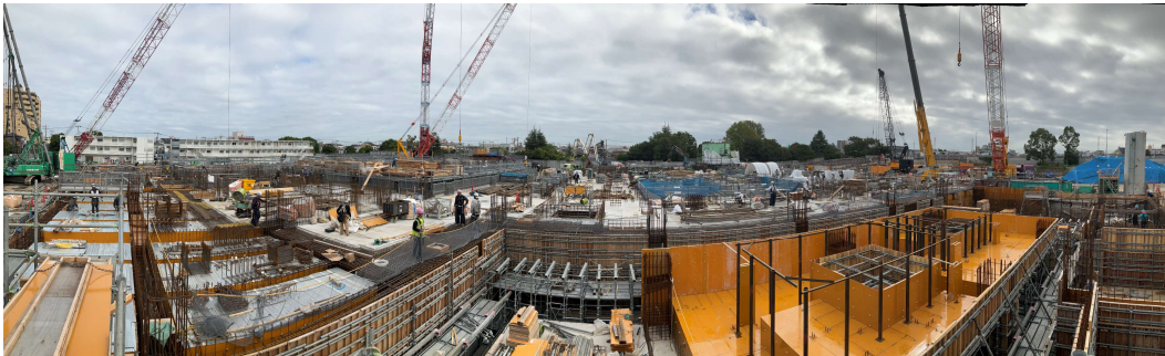
工場棟1階床躯体工事施工状況全景（西側）
