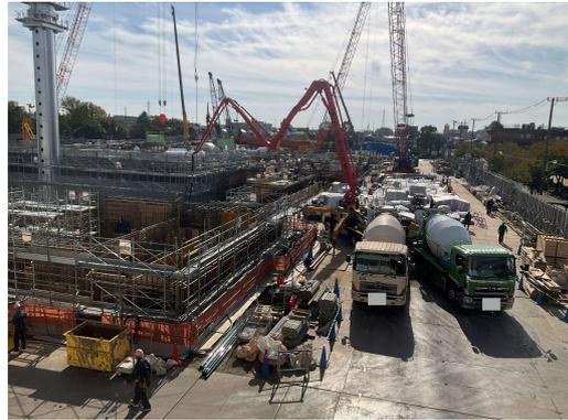
工場棟1階床躯体工事コンクリート打設施工状況
