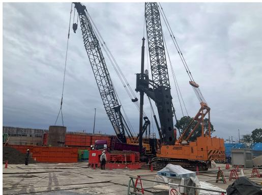
煙突現場打ち造成杭施工状況
