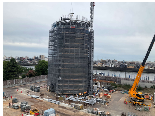
煙突地上躯体工事施工状況
