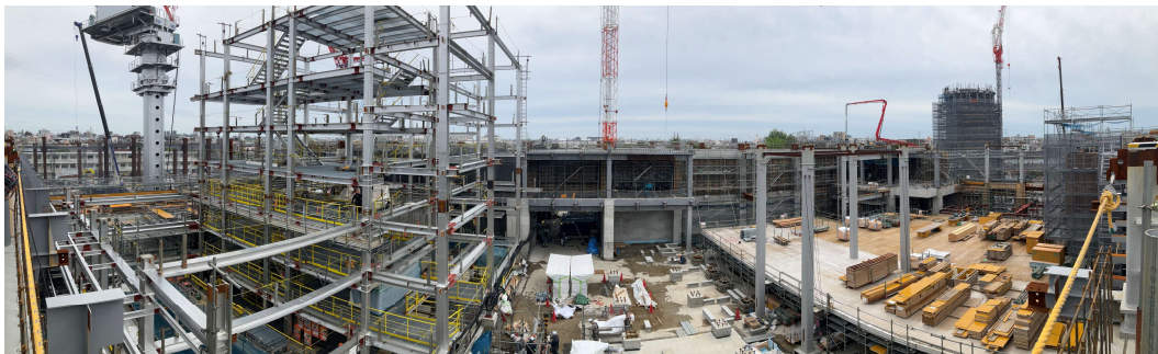
工場棟地上躯体工事施工状況（西側）
