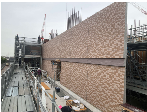
工場棟地上外装工事PCf工事施工状況（東側）
