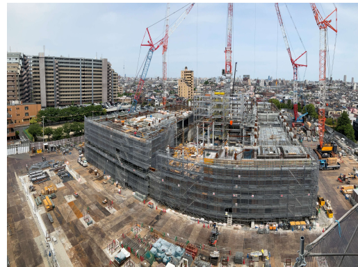
工場棟地上躯体工事施工状況（南側）
