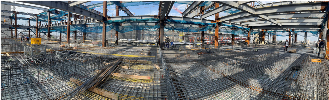
工場棟地上躯体工事施工状況（東側）
