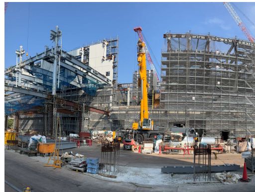
工場棟地上躯体工事施工状況（南側）
