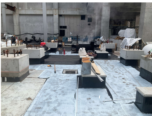
工場棟 1階床アスファルト防水工事施工状況（中央部）
