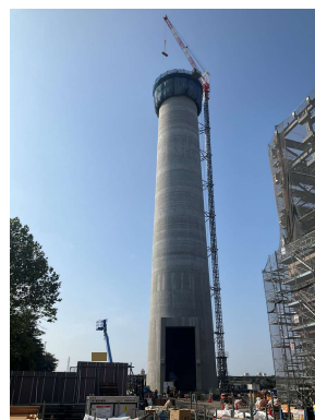
煙突地上躯体工事施工状況
