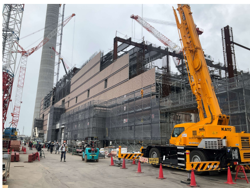
工場棟外壁PC板取付け施工状況（東側）
