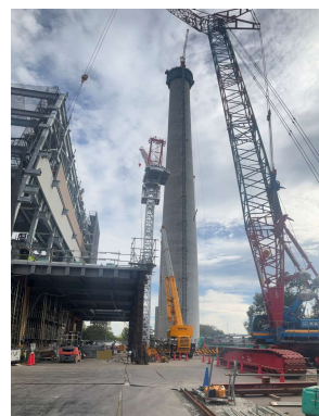
煙突地上躯体工事施工状況
