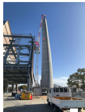
煙突地上躯体工事施工状況
