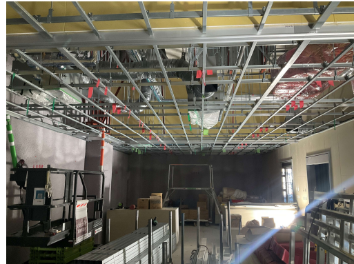
工場棟1階仕上げ工事天井地下地組立施工状況
