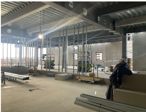
管理棟3階仕上げ工事間仕切り壁組立施工状況
