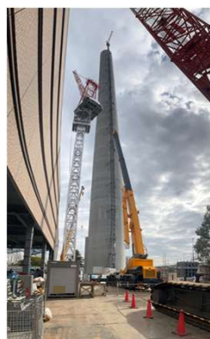
煙突地上躯体工事施工状況
