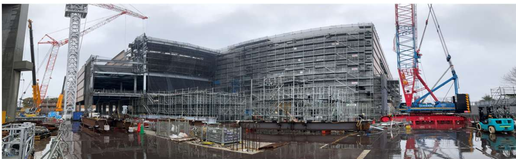
工場棟地上躯体工事施工状況（南東側）
