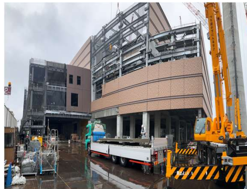
工場棟躯体外装工事施工状況（南西側）
