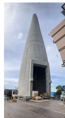
煙突地上工事施工状況
