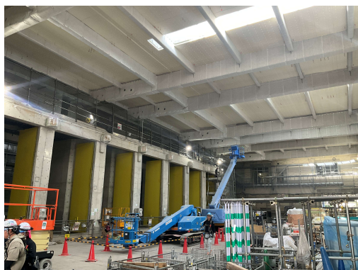
工場棟1階プラットフォーム仕上げ工事施工状況
