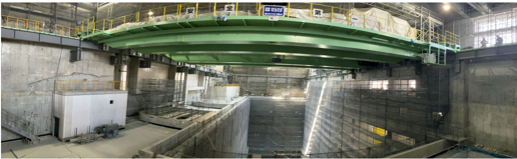
工場棟ごみバンカ施工状況
