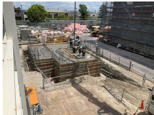
外構洗車棟躯体工事施工状況(北側)
