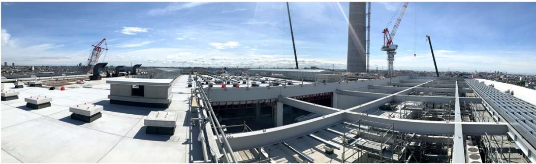
工場棟屋上施工状況
