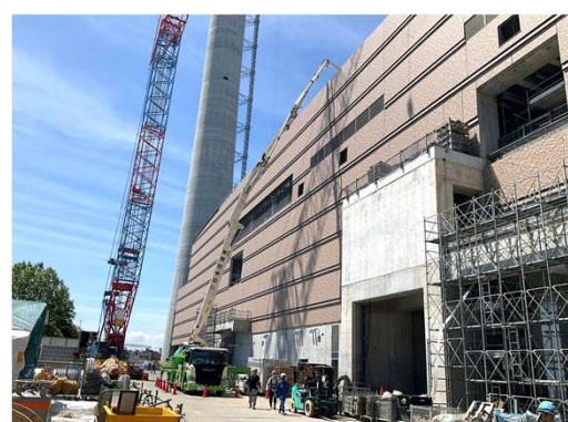
工場棟屋上コンクリート打設状況(東側)
