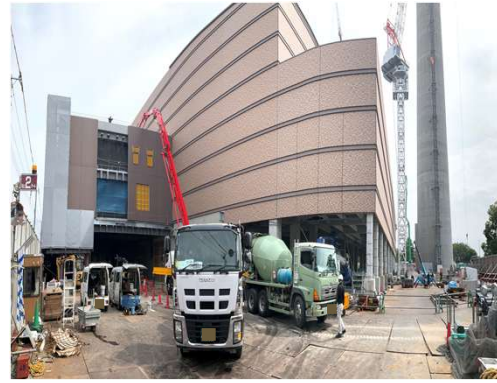
工場棟施工状況（北西側）
