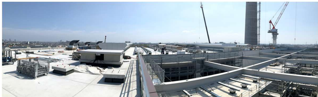
工場棟屋上全景
