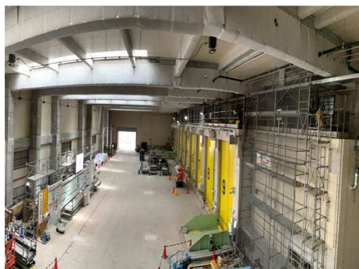
プラットフォーム施工状況
