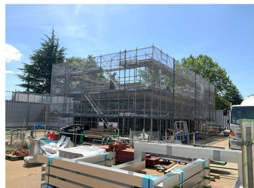
運転手待機所地上躯体工事施工状況
