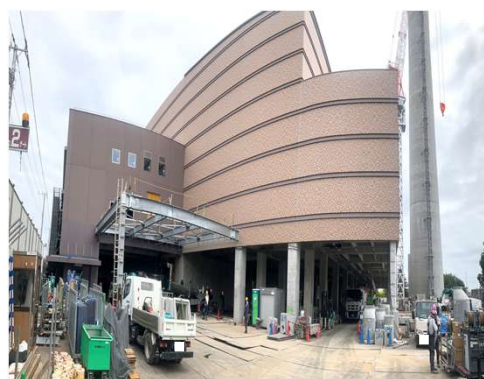
工場棟施工状況(南西)
