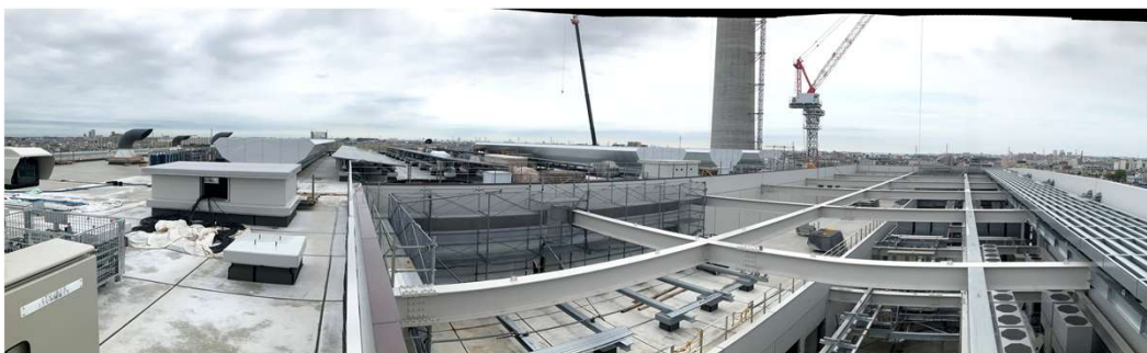
工場棟屋上施工状況
