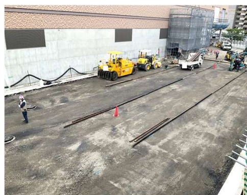
外構工事施工状況
