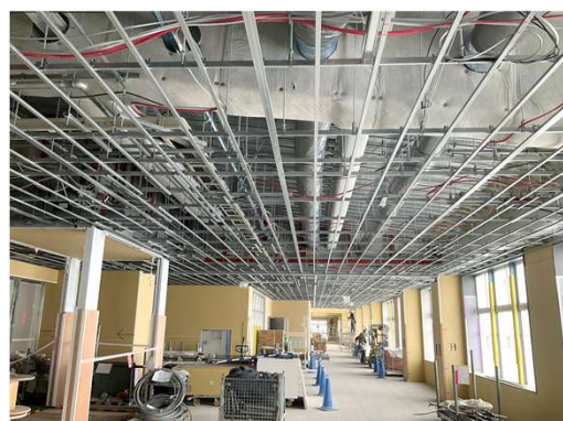
工場棟仕上げ工事施工状況
