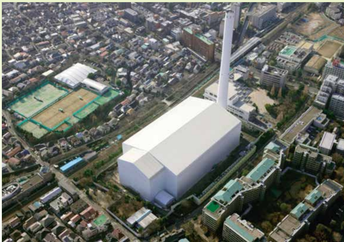
全覆い仮設テント設置例(杉並清掃工場)
